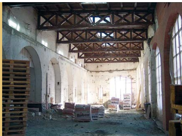
» Nové vazníky v budoucí galerii
