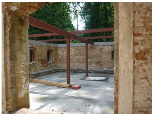
» Rekonstrukce podlah, betonové límce
