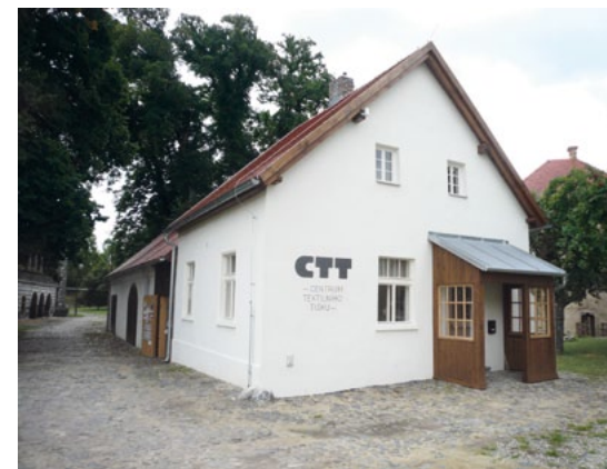
_objekty po zahájení rekonstrukce
