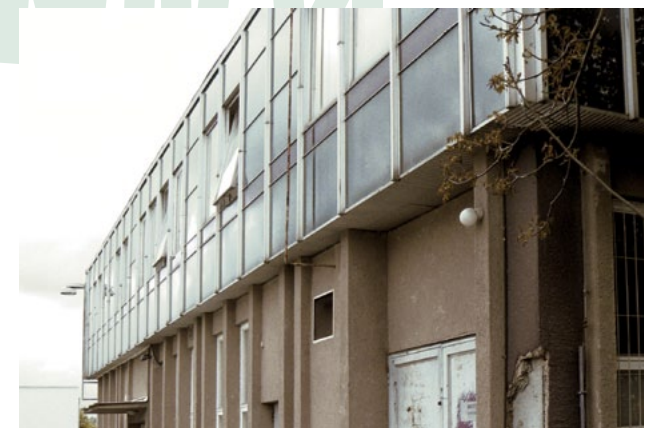
_výchozí stav z ulice Podveské
