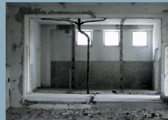
_interiéry centra před a po rekonstrukci
