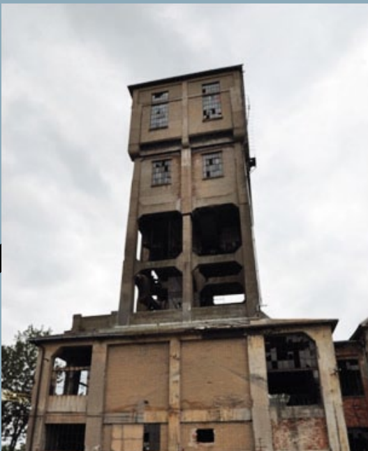
_těžní věže dolu KUKLA po rekonstrukci
