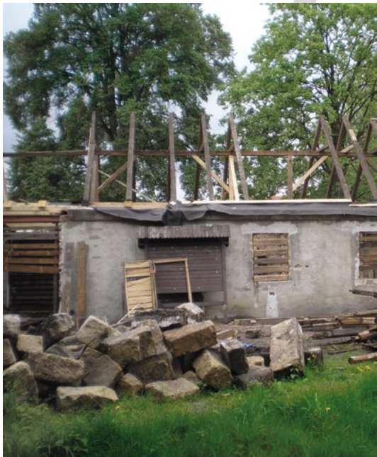
_průběh rekonstrukce bývalého hospodářského stavení
