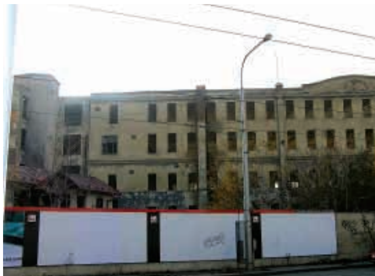
Severní strana, původní stav
