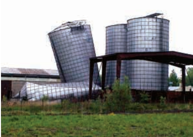
Demolice silážních věží
