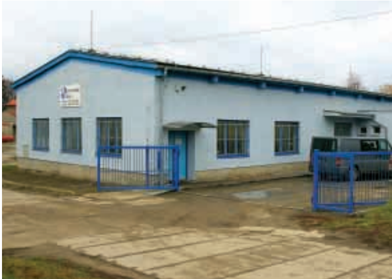
Jedna z rekonstruovaných budov
