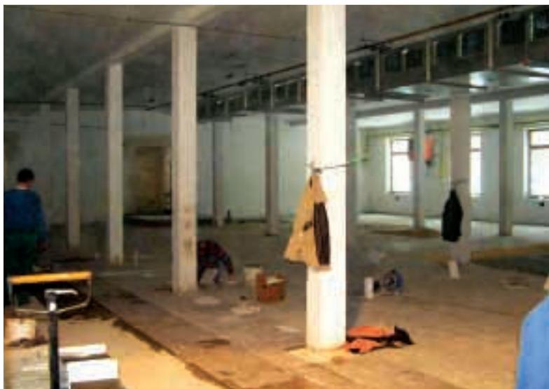
Pokládání podlah – únor 2005
