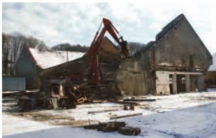
Výstavba stravovacího zařízení
