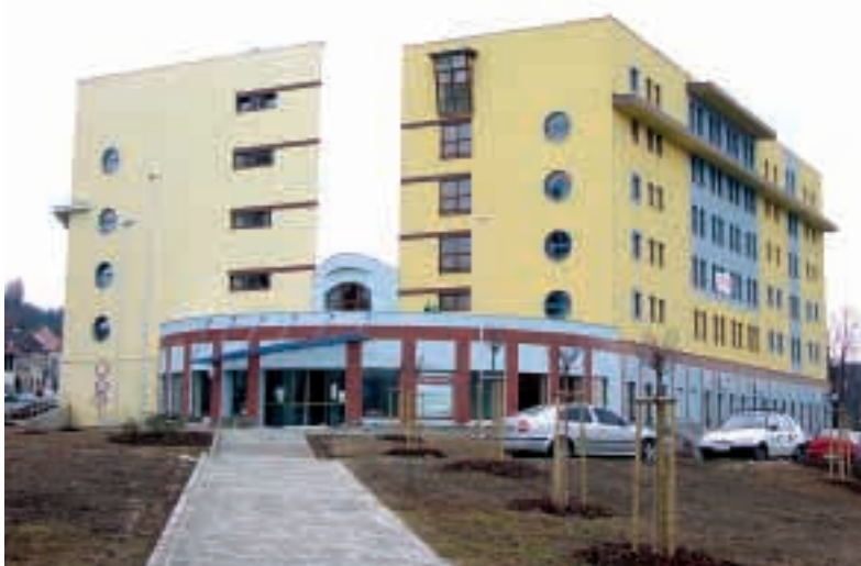
Severní strana po rekonstrukci
