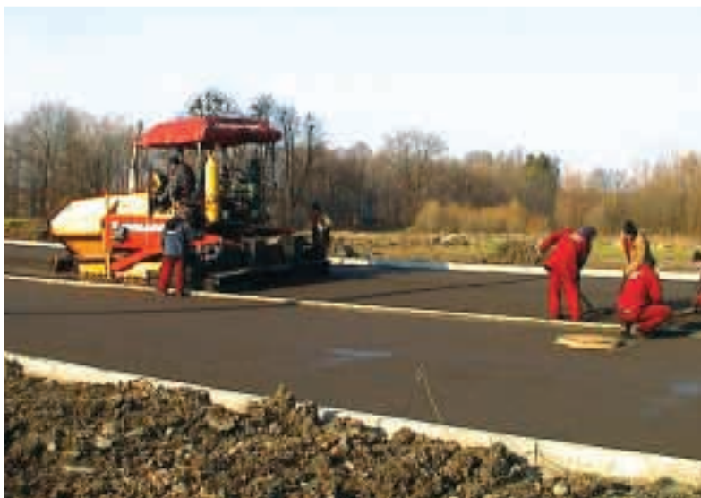
Výstavba dopravní infrastruktury
