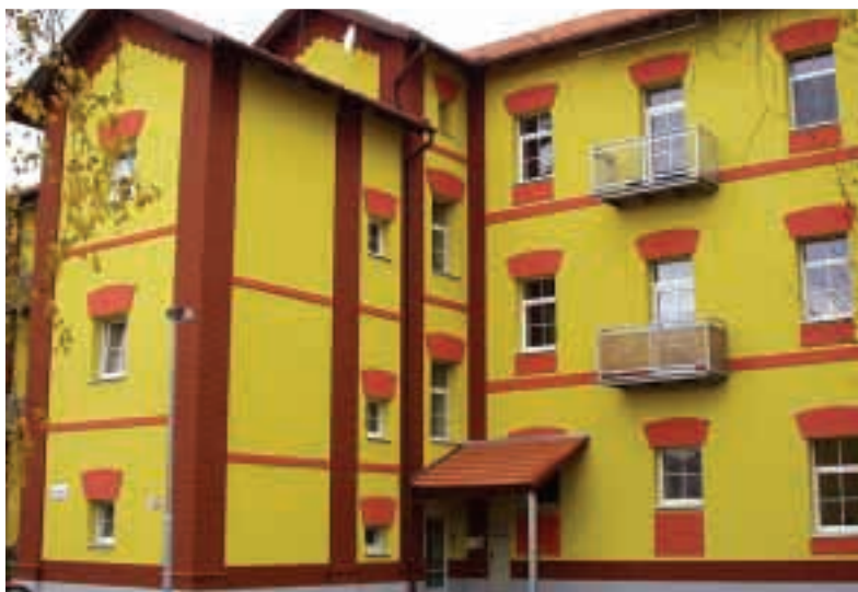
Velká kasárna – budova č. 5001 po rekonstrukci Zdroj: archiv MÚ Hodonín
