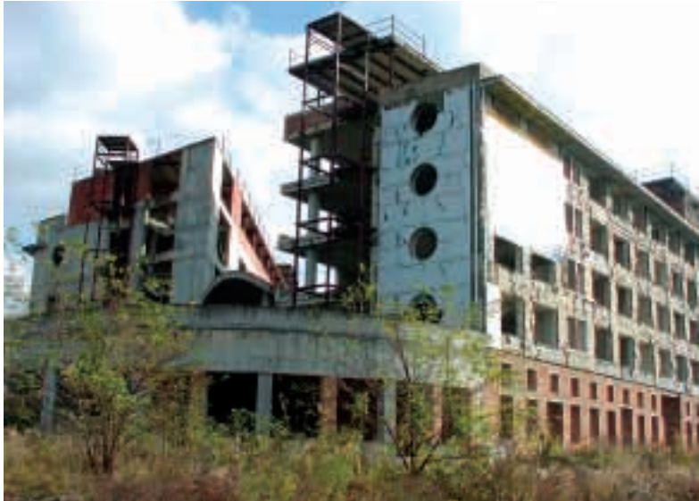
Severní strana před rekonstrukcí
