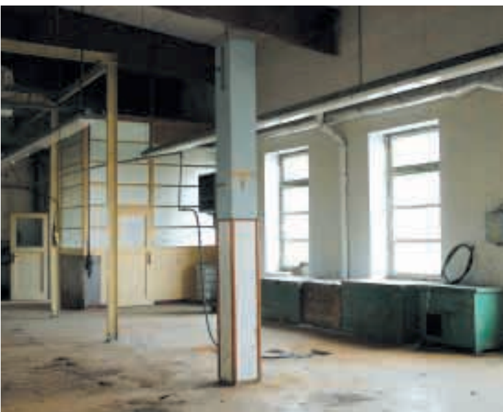
Výrobní hala v prvním patře – listopad 2004
