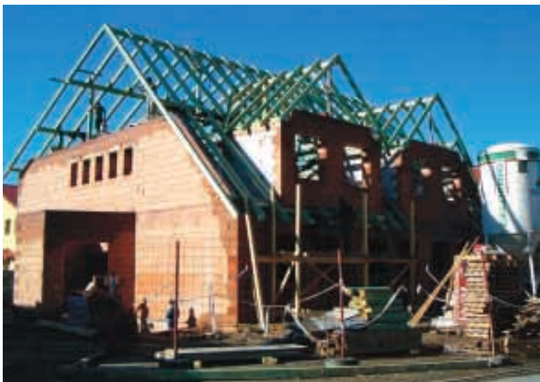
Výstavba stravovacího zařízení
