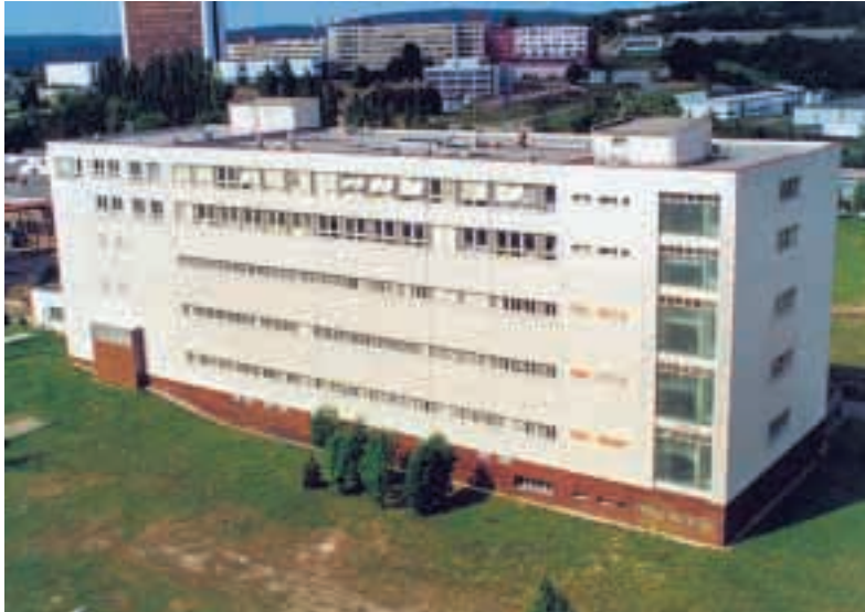
Budova bývalé Tesly Brno před rekonstrukcí
